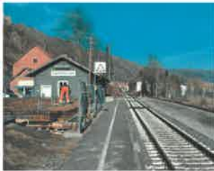
Blick vom Bahnsteig
