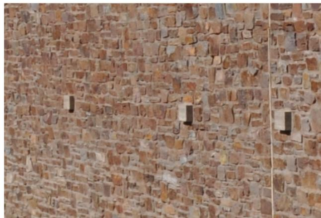
Beispielhafte Stützwand mit Natursteinverkleidung und Betonintarsien
